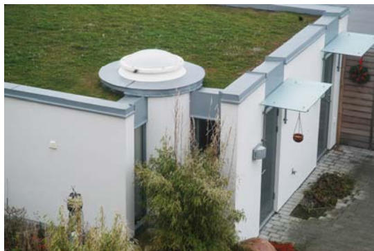
Bild; Grönt tak på byggnad i Helsingborg
