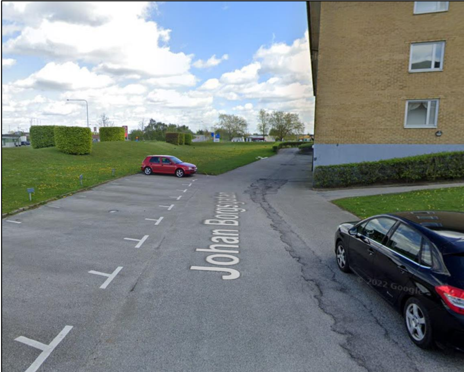
Figur 8.2: Johan Borgsgata där risk för stående vatten föreligger vid kraftiga regnhändelser. Källa: Google maps.
