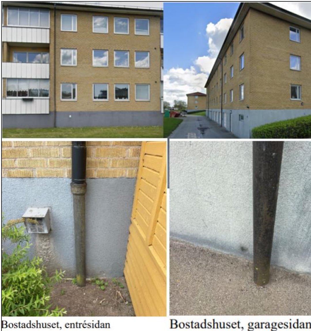
Figur 3.5: Avvattningen från tak via stuprör. Foto: NIRAS och Google maps.
