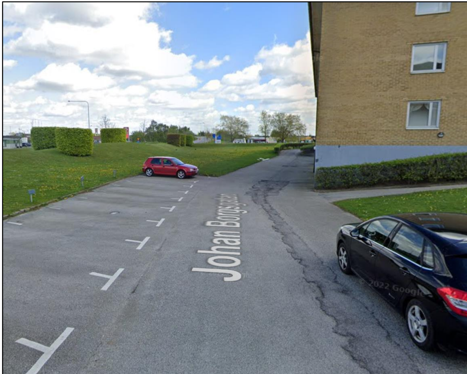
Figur 7-2. Johan Borgsgata där risk för stående vatten föreligger vid kraftiga regnhändelser. Källa: Google maps.
