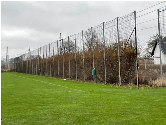
Häckar utmed järnväg.
