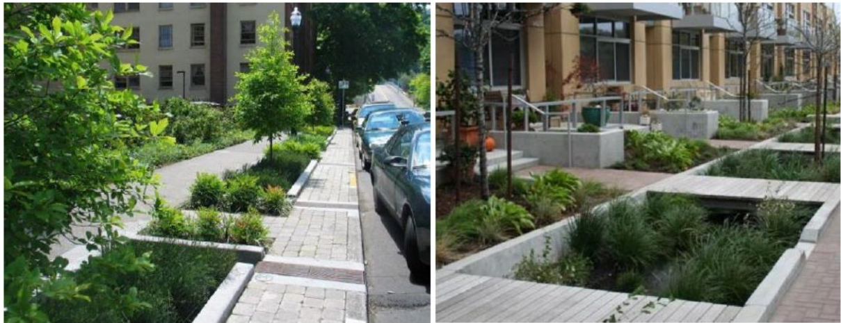
Exempel på regnbäddar mellan parkering och gångbana/byggnader.
