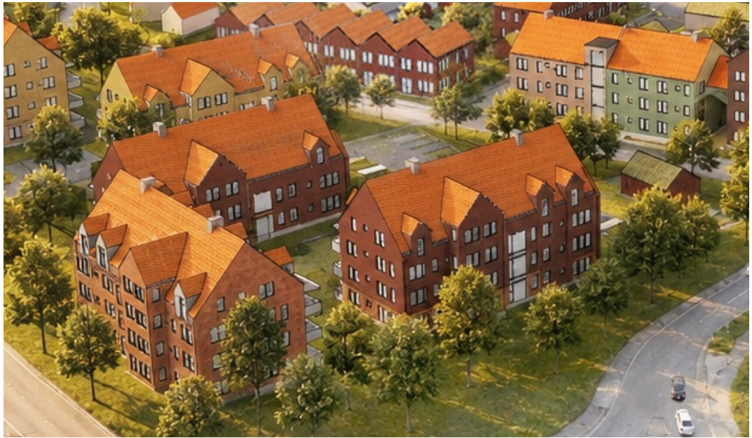
"NYA TUNNBRÖDSGÅRDEN" MED INSPIRATION FRÅN DEN HISTORISKA SKÅNSKA GÅRDEN MED DESS LÄNGOR OCH BRANTA TAKFALL.
