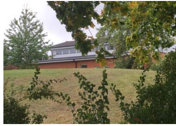
Malmö pingstförsamlings byggnad.
