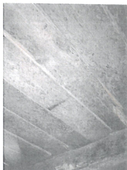
Bild 2. Bjälkar och råspont är missfärgad av mögelsvamp.
