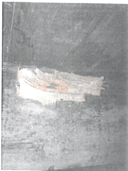
Bild 3. Rötskadad golvbjälke.
