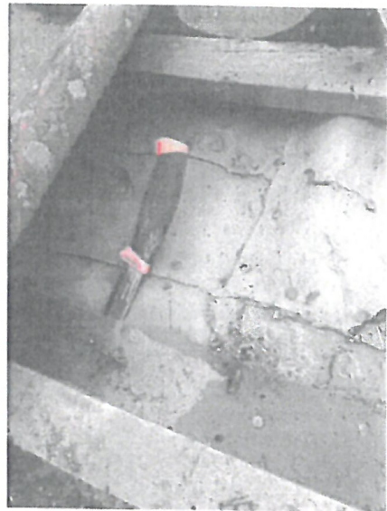
Bild 6. Äldre takpapp med lagningar och sprickor.
